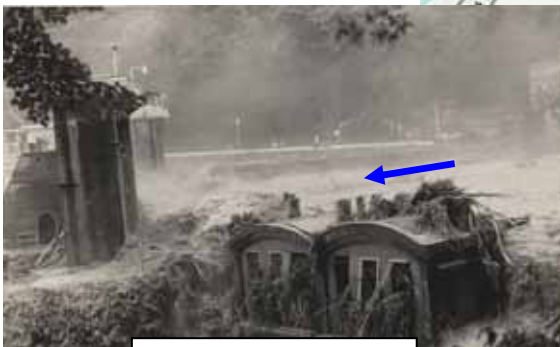
増水時の愛本えん堤
