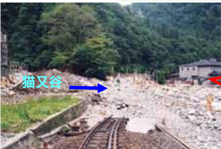
流出土砂で埋没した黒部峡谷鉄道 (猫又谷出合付近)
