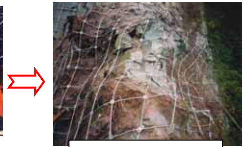
落石防止対策工の施工
