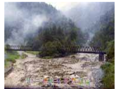
CCTVカメラによる流況監視及び現地画像情報の提供
