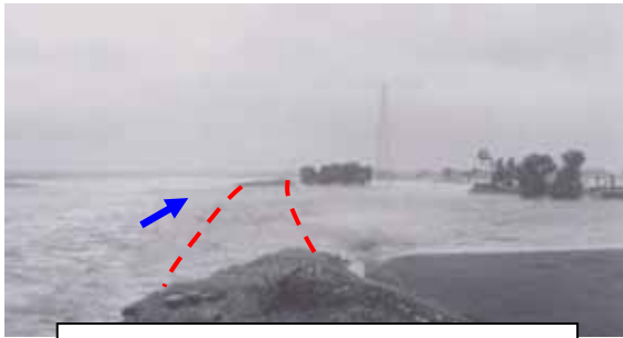
黒部川の増水により破堤した南島堤
