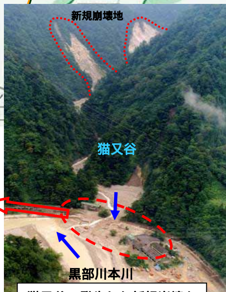
猫又谷で発生した新規崩壊と 出合付近の土砂流出被災状況
