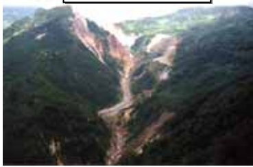
祖母谷崩壊地
