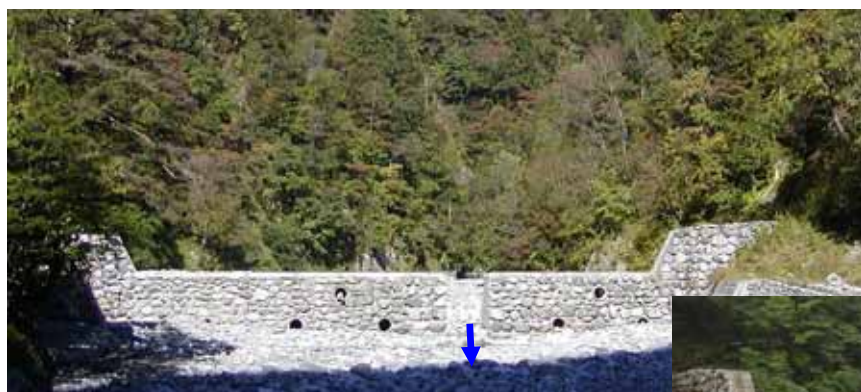
平成15年度に完成した 黒雑川第4号砂防えん堤 (堤体前面に現地採取の 巨石張加工を採用)
