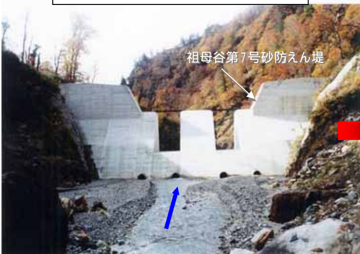
出水前えん堤上流側堆砂状況
