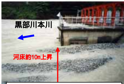
河床上昇で埋没した関西電力 猫又ダム旧ディーゼル室
