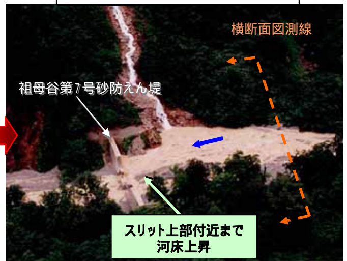
出水2日後の土砂捕捉状況
