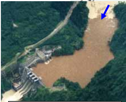
大量の流木が滞留した 関西電力出し平ダム貯水池
