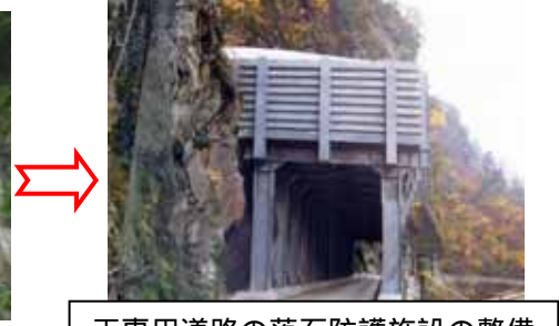
工事用道路の落石防護施設の整備
