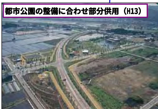
都市公園の整備に合わせ部分供用 (H13) ① 下折立浦佐(停)線上空より湯沢方面を望む
