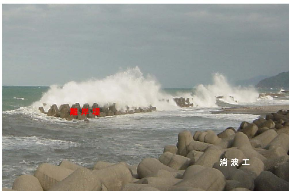
写真2 沖合施設(離岸堤)による消波状況（第二工区）
