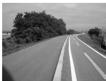
自転車道と共同施工後の堤防
