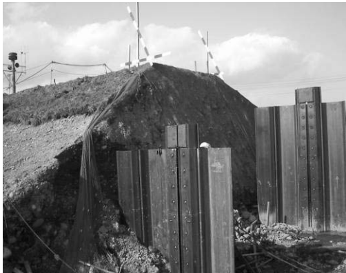
広幅鋼矢板(湯川樋管改築)
