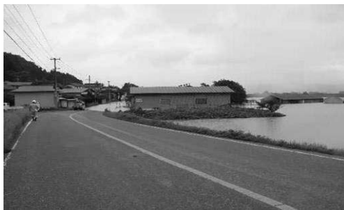
道路冠水被害状況 （喜多方市山崎地先）
