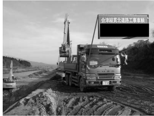
土砂搬出状況
