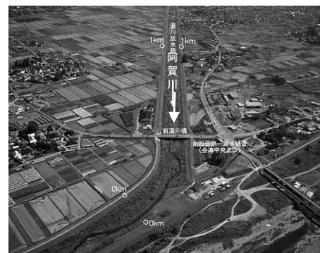
阿賀川と湯川放水路
