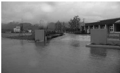
特別養護老人ホーム内水被害状況 （会津本郷町大石地先）
