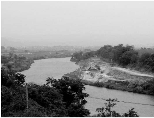
下流狭窄部改修事業(津尻地区)
