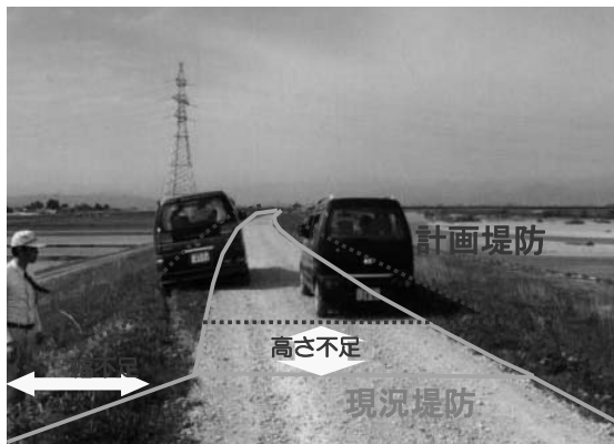
堤防の拡幅・嵩上げ（弱小堤防）
