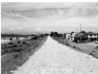
整備前の堤防
