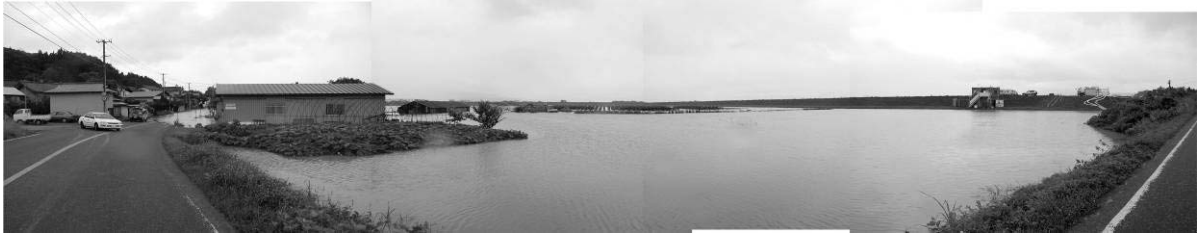
田畑冠水被害状（喜多方市山崎地先）
