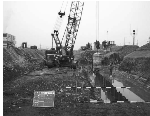
打設状況(湯川樋管改築)
