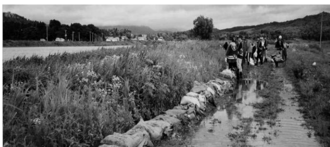
水防活動（旧宮川越水箇所）
