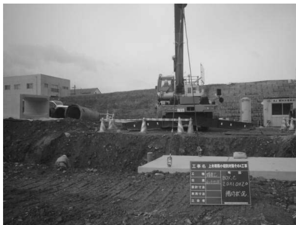
プレキャスト暗渠工据付状況
