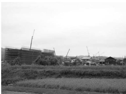
北陸新幹線新駅建設状況
