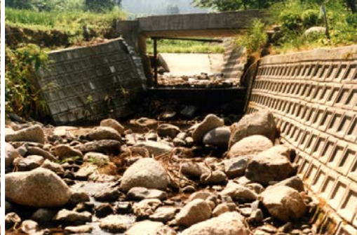
豪雨により土砂流出 (姫田川支川)
