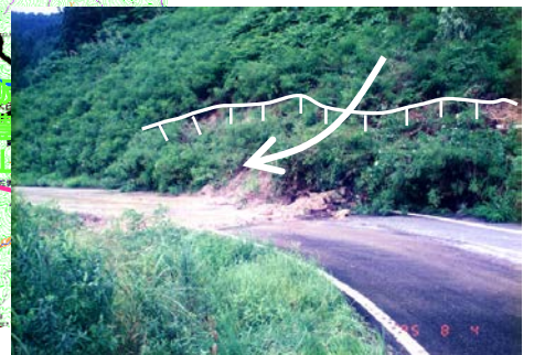
集中豪雨により土砂崩落した滝谷地区 (平成7年8月)
