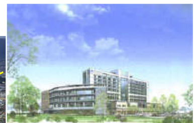
H19.4移転開業した新県立新発田病院
