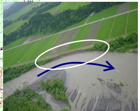
胎内川左岸堤防欠損 (平成17年6月)
