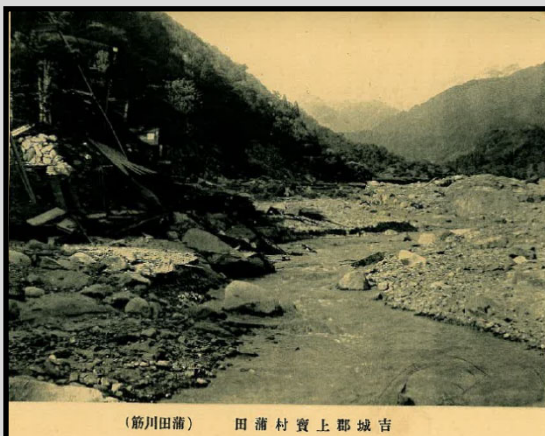
大正9年6月大洪水による蒲田温泉流失被害状況
