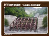
白谷砂防堰堤群 (白谷第4号砂防堰堤)
