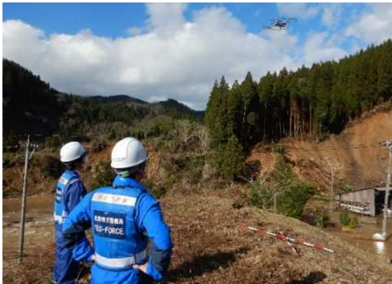
ドローンによる河道閉塞状況調査(河原田川)
