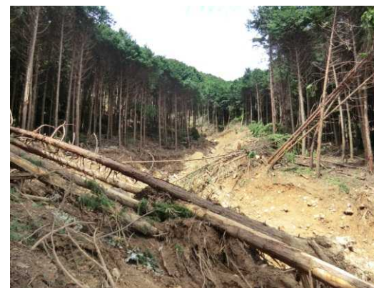
新たに谷となって土砂が流出した箇所
