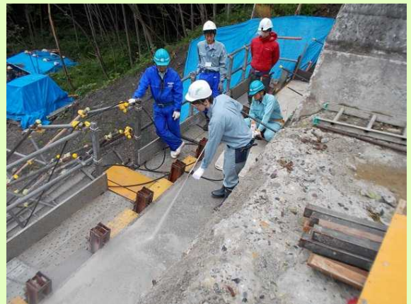
建設業体験（コンクリートの脆弱層除去）
