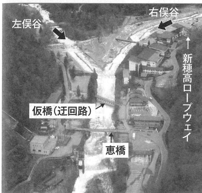
取り壊される恵橋と迂回路になる仮橋
