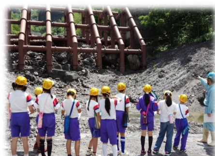
▲実際の砂防堰堤を見学
