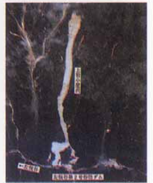
平成9年7月 左俣谷土砂崩壊
