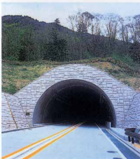
安房トンネル
