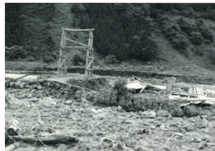
流出した平湯川 村上橋
