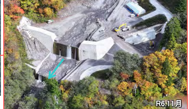
白谷第1号砂防堰堤改築
