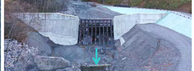
白谷第5号砂防堰堤改築
