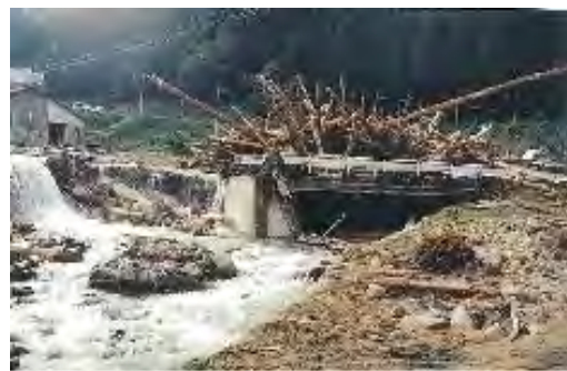
平成11年9月 橋梁部の閉塞状況(飛騨市河合町稲越川)
