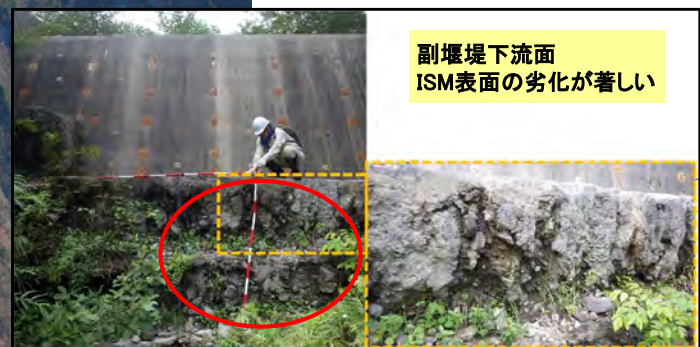
餌掛谷上流第2号砂防堰堤改築
