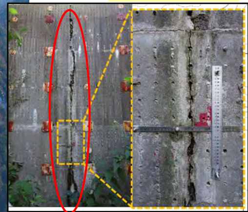
本堰堤上流面 天端から鉛直方向の亀裂
