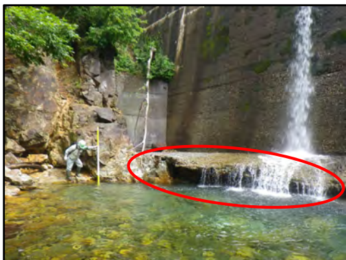
本堰堤の基礎洗掘状況
