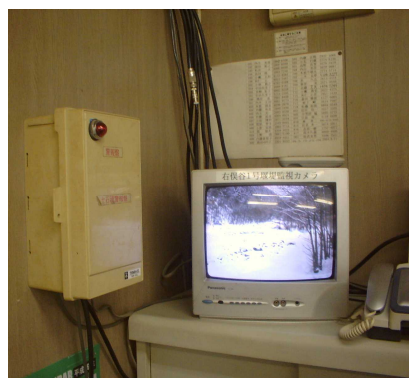
監視モニター設置
