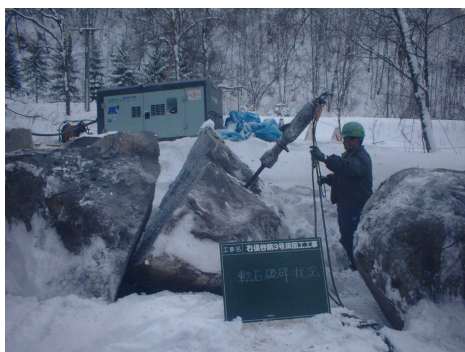
削孔後転石破砕を実施する 転石破砕状況（ダルダ使用）
