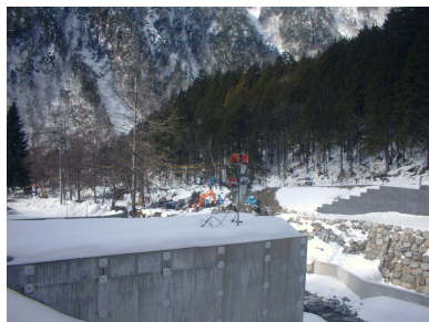
回転灯、サイレンの設置
