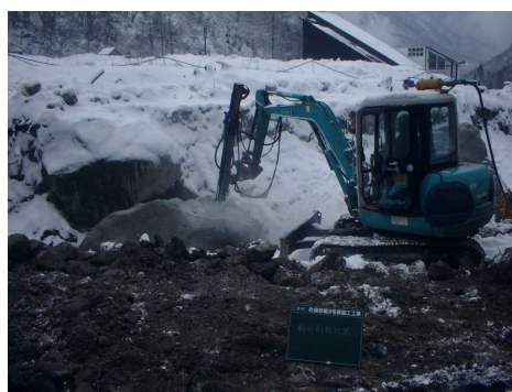
削孔後転石破砕を実施する 転石破砕状況（ダルダ使用）
