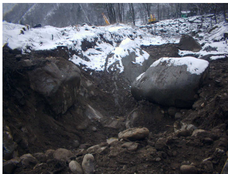
垂直壁部分の転石出土状況
