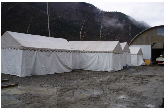
(養生ハウス製作)
