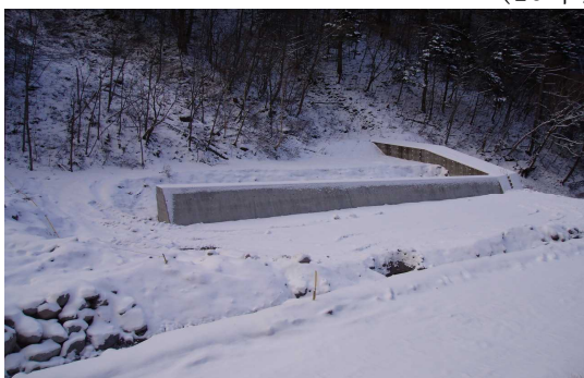
(19年度完成 下流護岸)
