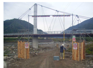
高さ制限設置
