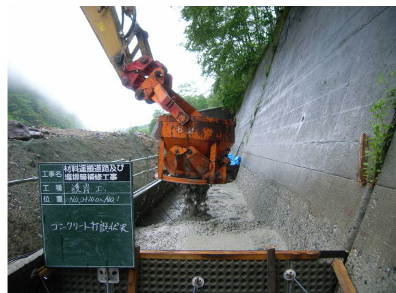
生コンクリート打設状況
