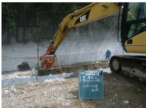
生コンクリート打設状況
