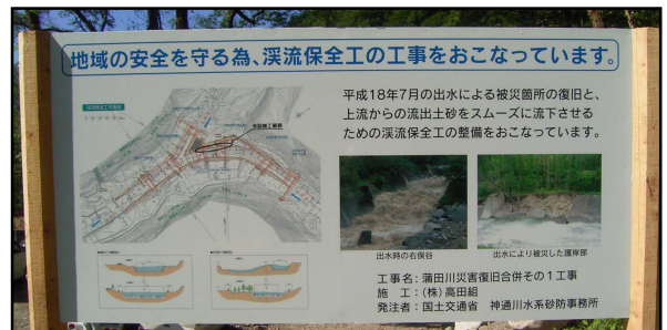
【工事説明看板】
