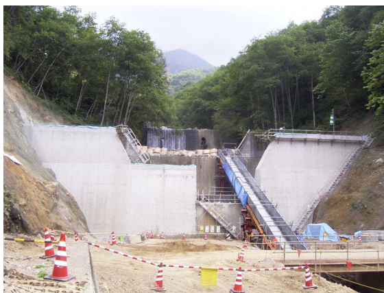
施工時通水状況
