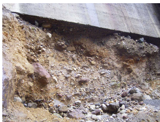
既設第6号副堰堤
