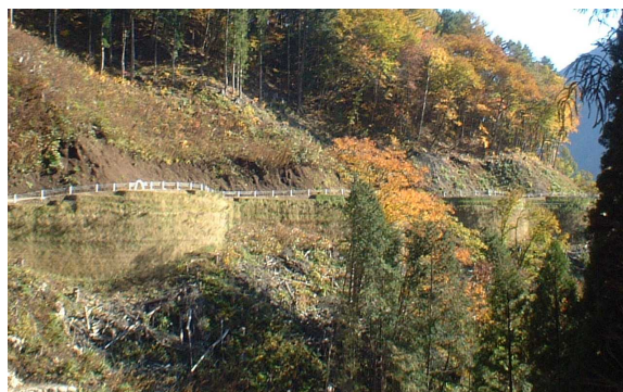
完 成 (付帯道路工及び法面工：正面より)
