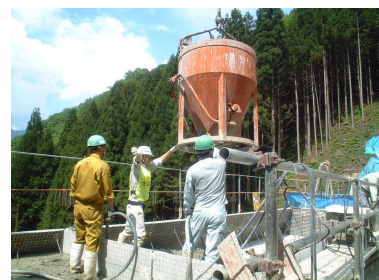
蛍光ベストの着用(合図者) ※クレーンによるコンクリート打設状況（合図状況）
