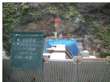
蛍光ベストの着用(合図者) ※クレーンによるコンクリート打設状況（合図状況）
