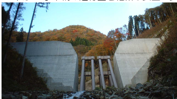
完 成 (本堰堤工：下流側より)
