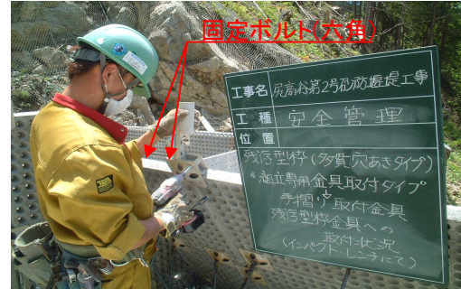
※手摺り設置完了・・・写真-5
