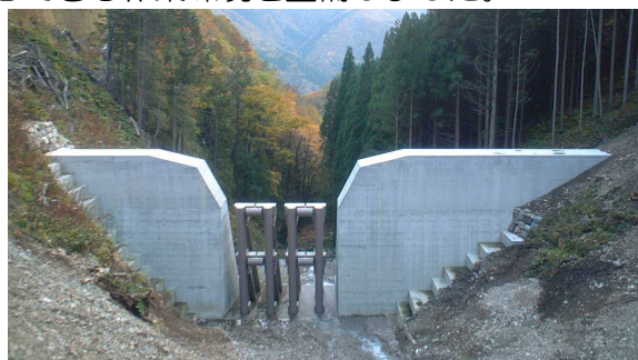
完 成 (本堰堤工：上流側より)
