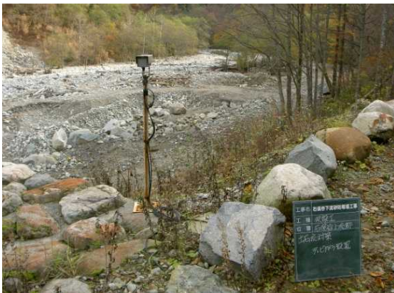
右俣谷1号砂防堰堤監視カメラ設置状況
