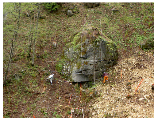
転石保護工(ワイヤーロープ吊工) 測量状況
