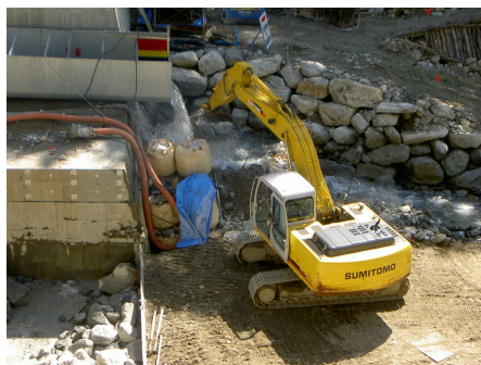
粗石洗浄 バックホウ(スケルトンバケット)により粗石洗浄。
