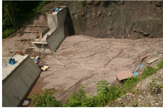
岩坪谷 4 号えん堤(施工中)の堆砂状況
