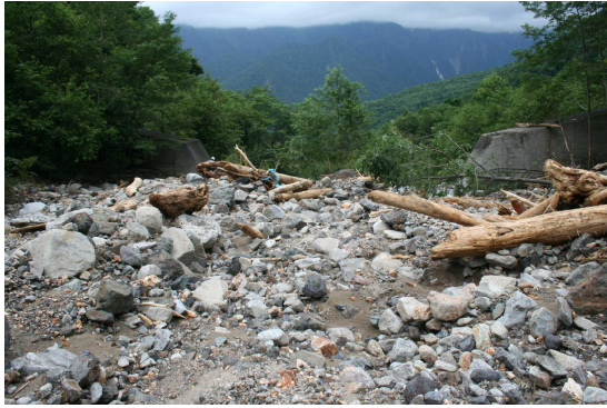
外ヶ谷 10 号えん堤の堆砂状況
