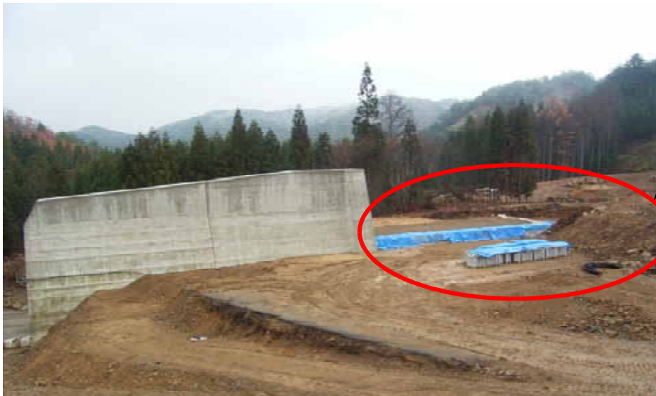
ソイルセメント工施工箇所
