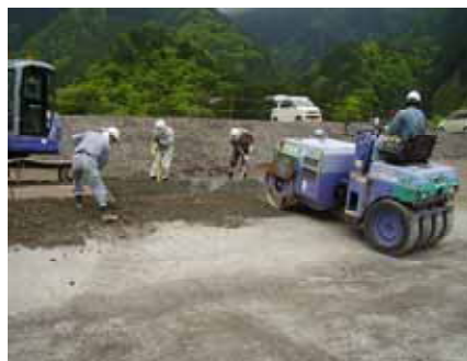
敷均転圧状況
