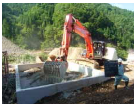
セメントと土砂の攪拌状況
