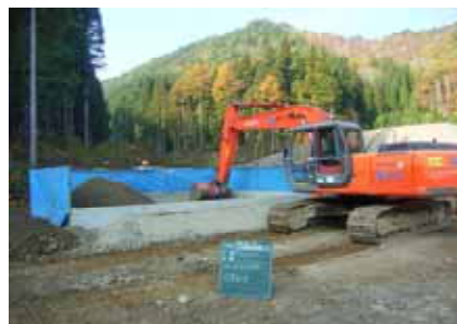
加水及び混合状況
