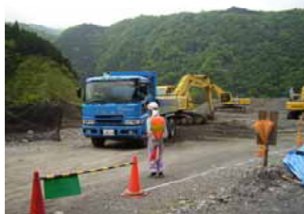
積込運搬状況
