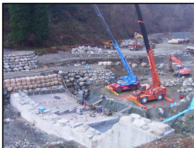
【作業状況全景】
