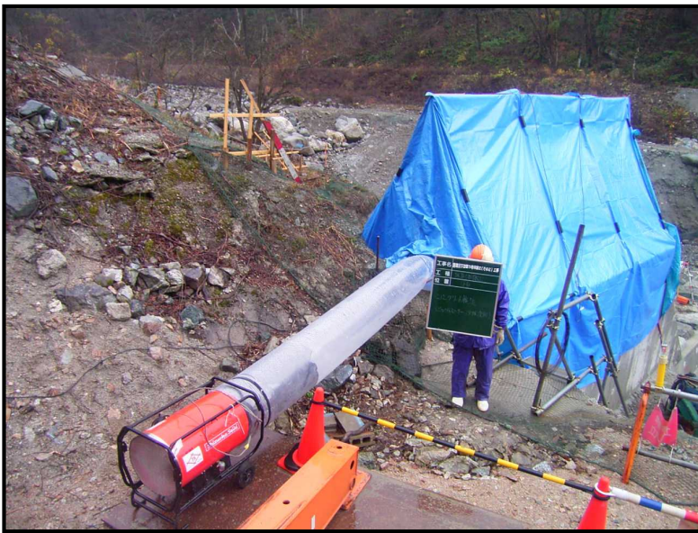
【熱養生状況・外側】
