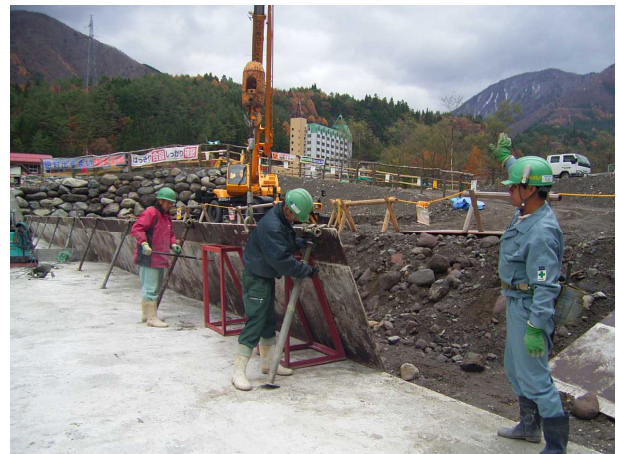
鋼製鉄板型枠建て込み状況
