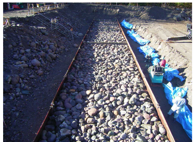
粗石投入完了
