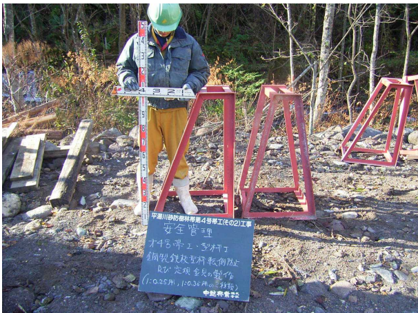
鋼製鉄板型枠倒れ防止台座定規
