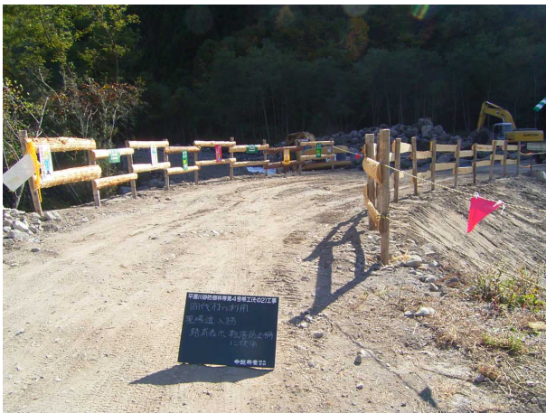
工事用道路の転落防止柵設置
