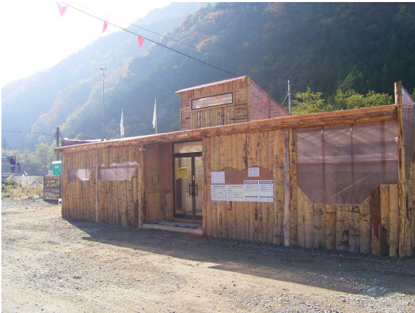
現場事務所周りの囲い
