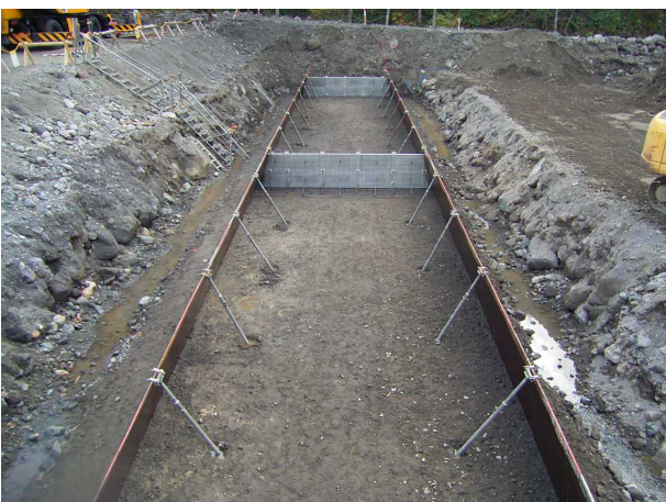
鋼製鉄板型枠建て込み完了
