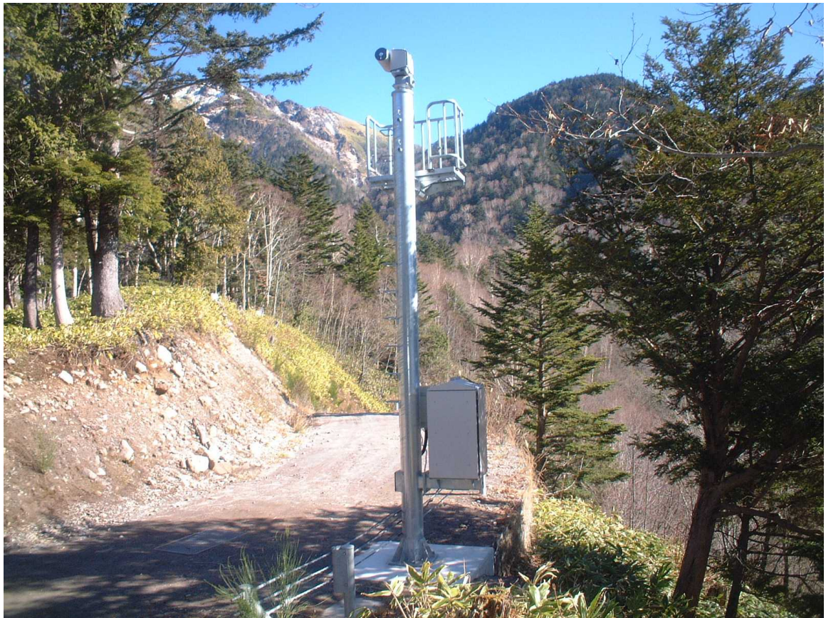
工事完成 (CCTVカメラ装置)
