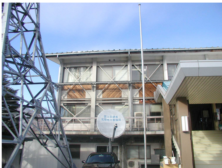
南側完成写真
