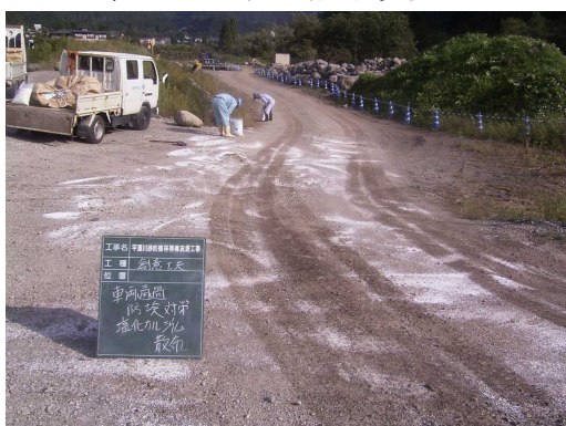
塩化カルシウム散布状況
