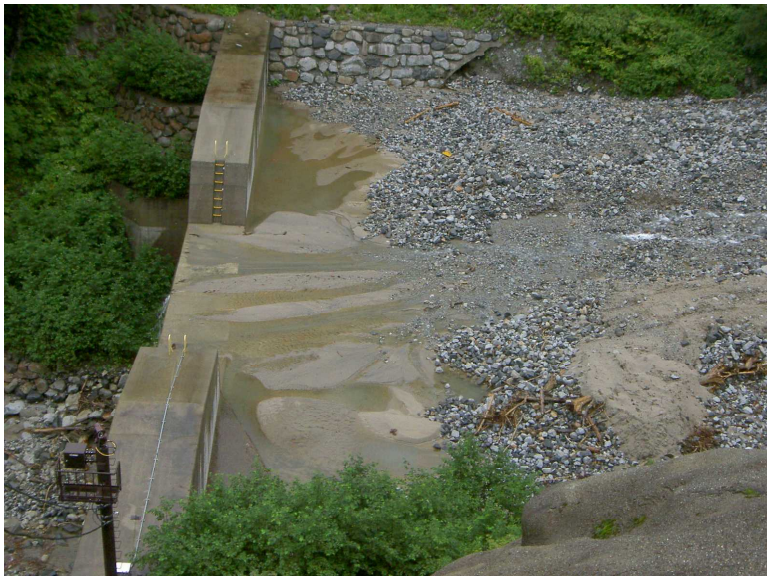
写真20 8号堰堤貯砂状況
