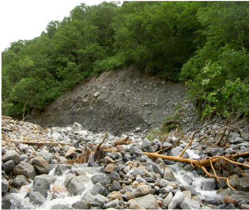
写真25 洗掘による崩壊跡
