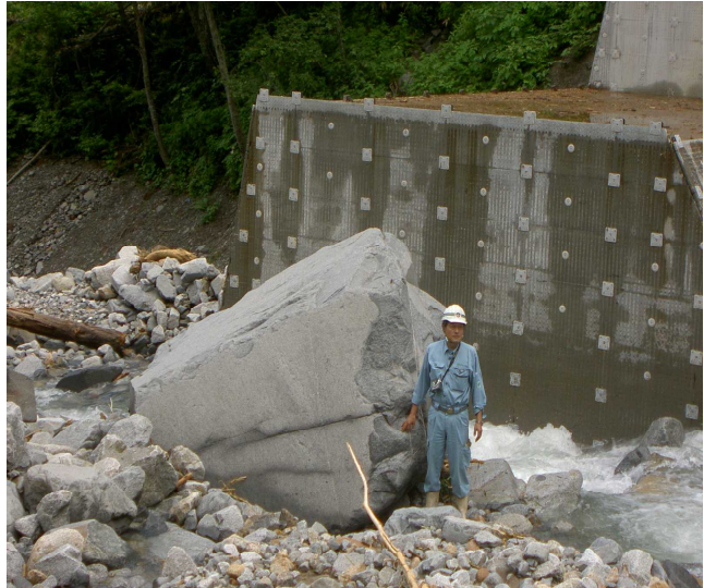
写真26 土石流により流下した巨石
