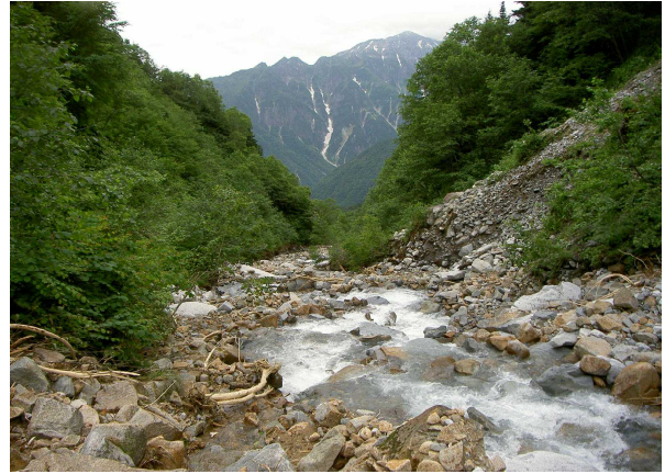
写真19 土石流後上流部崩落跡
