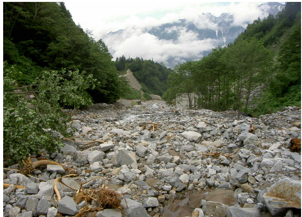
写真21 10号堰堤～8号堰堤(写真の最下流が8号堰堤)
