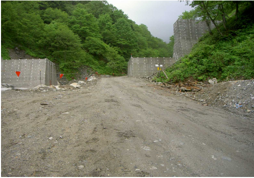
写真13 仮設道路被災前
