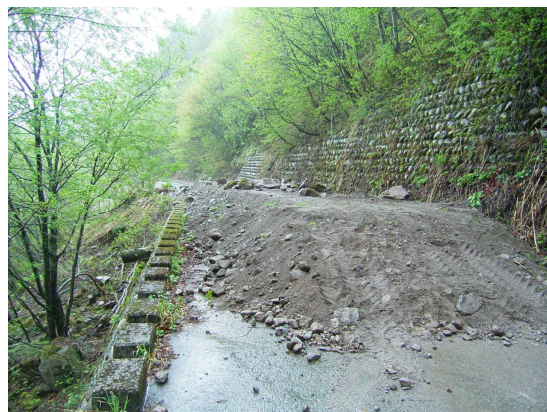
(浮石除去完了)
