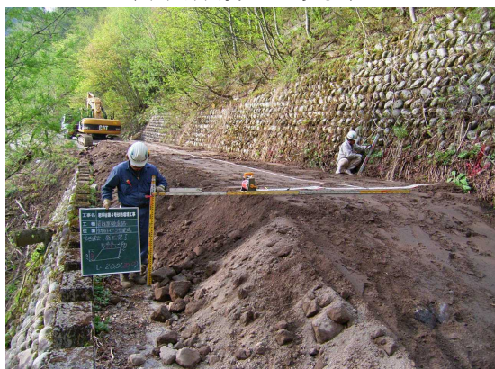
(路面保護盛土状況)
