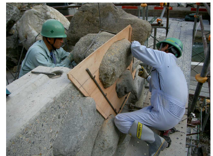
③ 巨石設置
