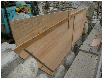
① 型枠設置
