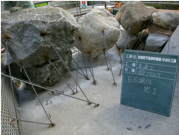
④ 鉄筋固定状況
