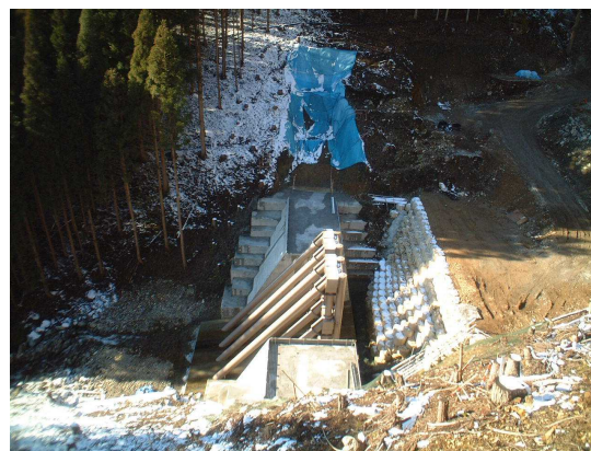
平成18年度 部分完成 (本堰堤工:左岸側より)
