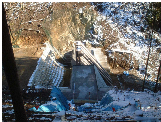
平成18年度 部分完成 (本堰堤工:右岸側より)
