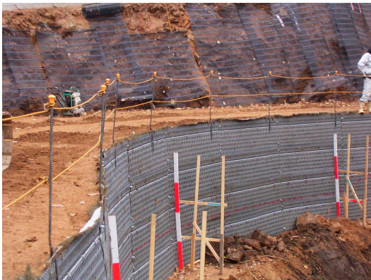
※前年度(平成 17 年)の転落防止用措置状況(φ13mm 異形鉄筋+金具+ロープ緊張)
