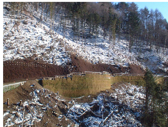
平成18年度 部分完成 (付帯道路工及び法面工:正面より)
