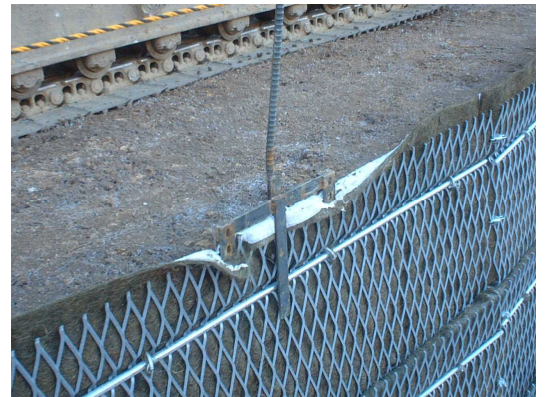
※前年度(平成 17 年)の転落防止用措置状況(φ13mm 異形鉄筋+金具+ロープ緊張)
