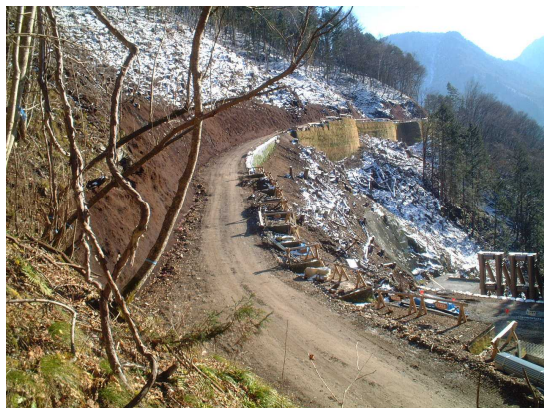
平成18年度 部分完成 (付帯道路工及び法面工:終点側より)
