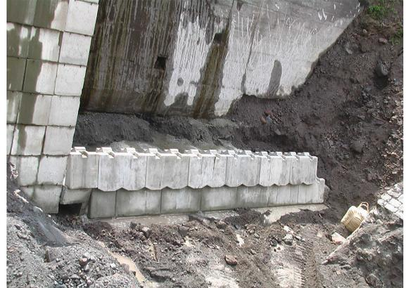
この写真の様にクレーンでブロックの移動・据付を行い、遠隔操作式バックホウはブロックの回転を止めるなどの補助的な作業を行い、施工性の効率を図りました。
