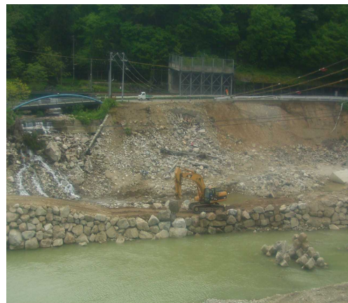
巨石積み状況
