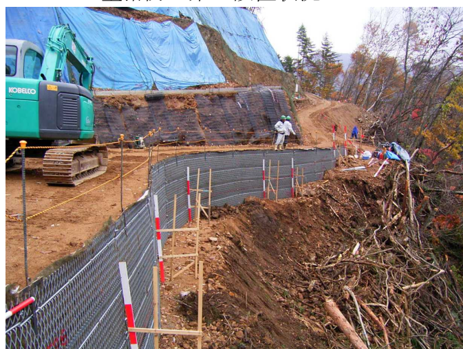
墜落防止策の設置状況
