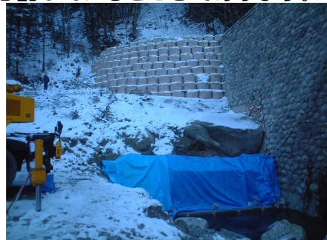
右俣谷1号堰堤下流 右岸 護岸工（巨石積）
