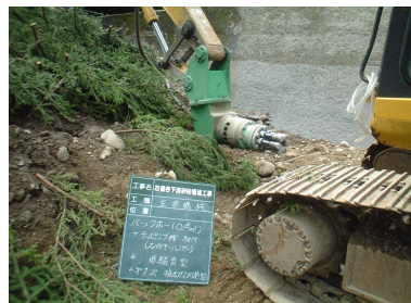
バックホー(0.8m 3 )装着後
