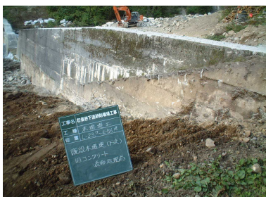
既設堰堤左岸側 ハツリ前
