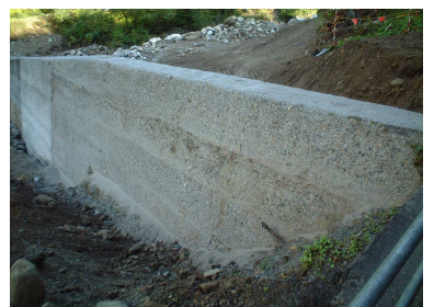
既設堰堤左岸側 ハツリ後
