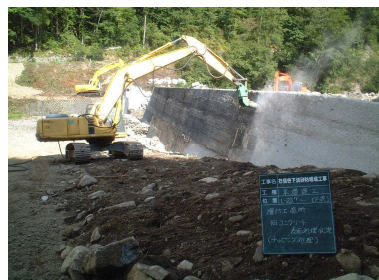
ハツリ状況（下流側）
