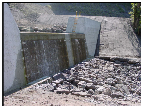
【副堰堤下流側】
