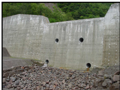
【本堰堤下流側】
