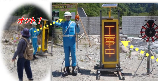
【写真-12 現場入口にもガードマンロボ】
