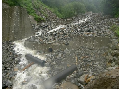
【令和2年 14号堰堤左岸側斜面崩落】
