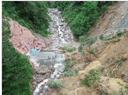
【令和2年 14号堰堤左岸側斜面崩落】
