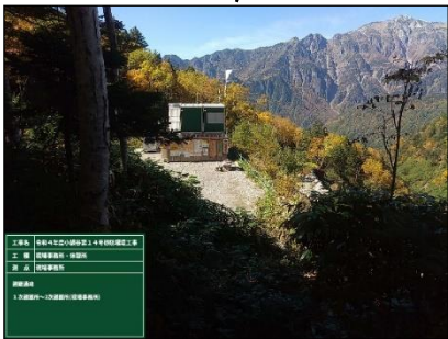
第2避難所（現場事務所）
