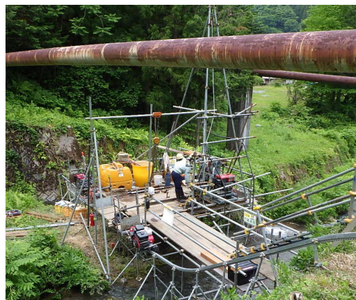
【写真2 ボーリング実施状況】
