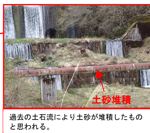
【写真 1 R6-iw3 地点付近全景(土砂堆積状況)】
