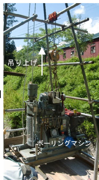
【写真3 スライド装置によるボーリングマシン移動状況】
