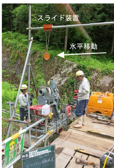
【写真3 スライド装置によるボーリングマシン移動状況】
