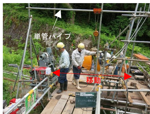
【写真6 スライド装置状況】
