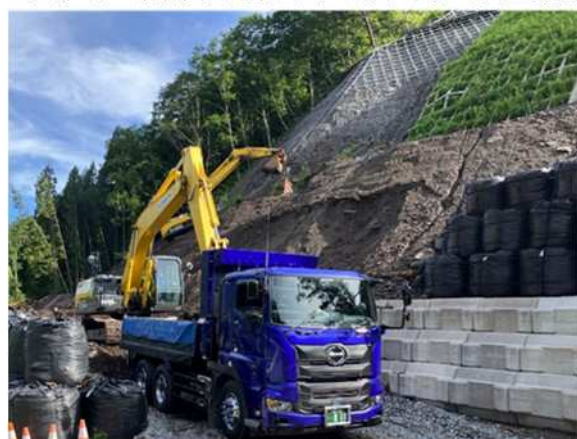
【土砂積込状況】
