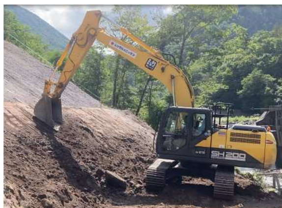
【砂防土工施工状況】
