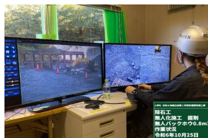
【写真-5 無人化施工掘削状況】
