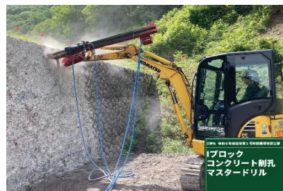
【写真-9 削孔状況】
