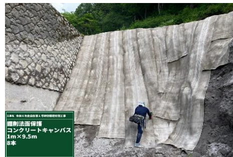
【写真-7 コンクリートキャンバス】
