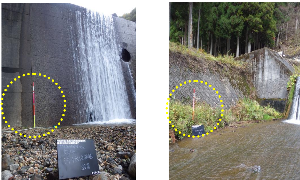
河床に設置した河川水位の指標（左：外ヶ谷地区、右：岩坪谷地区）
