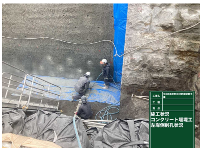
写真-4 従来工法(端部)
