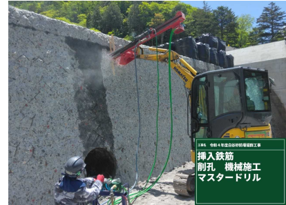
写真-6 削孔 施工状況
