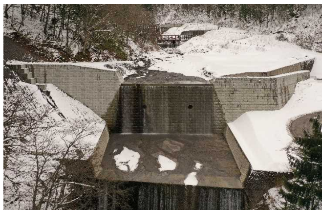
写真-2 白谷第1号砂防堰堤 完成 12.5 撮
