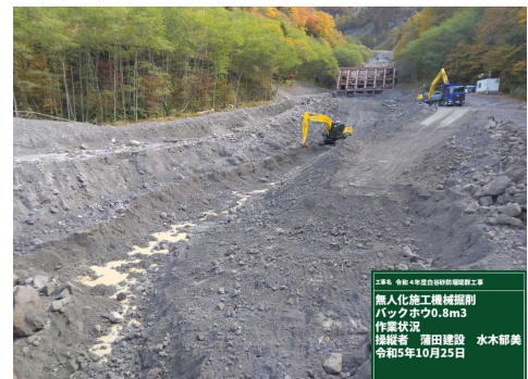
写真-9 無人化施工状況
