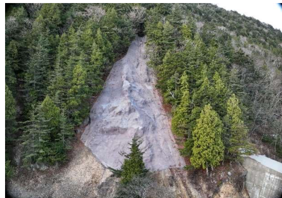
右岸法面(完成)
