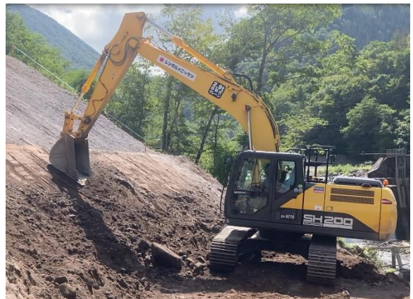
【砂防土工施工状況】
