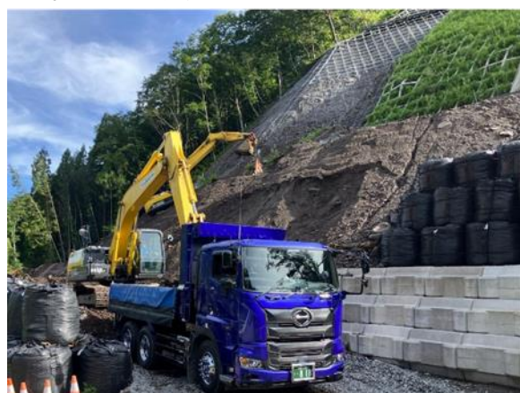
【土砂積込状況】
